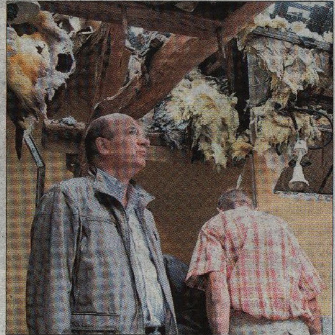
Le maire P. Laplace et ses adjoints mesurent l'ampleur des dégâts et prennent les premières décisions pour reloger les services.
